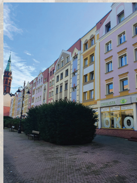
Czyszczenie i malowanie elewacji ul. Złotoryjska 2-14
