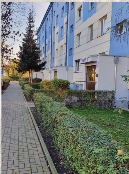
Remont wiatrolapów przy ul. Fredry 18-24
