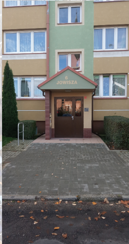
Remont dojścia do klatki ul. Jowisza 6
