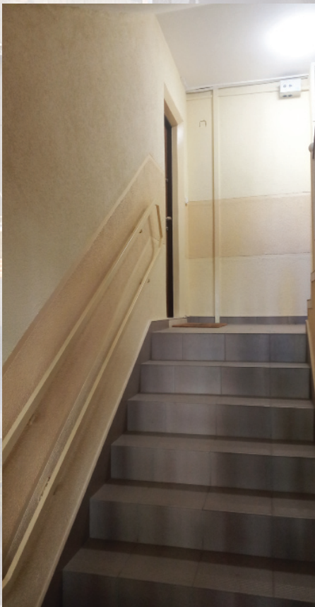
Remont klatek ul. Marsa 2, Merkurego 7-12, Jowisza 9-12
