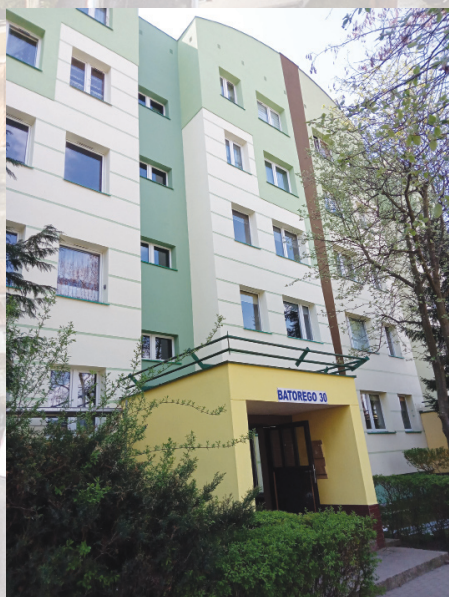
Czyszczenie i malowanie elewacji ul. Batorego 28
