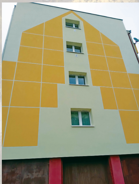
Wykonanie nowego ocieplenia ściany przy ul. Oświęcimskiej 17
