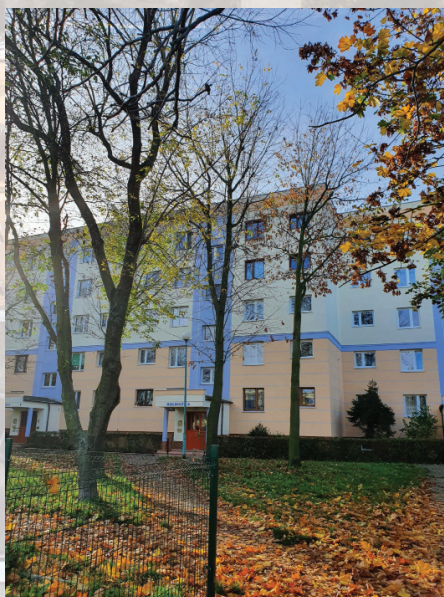
Czyszczenie i malowanie elewacji budynku ul. Rolnicza 4-10
