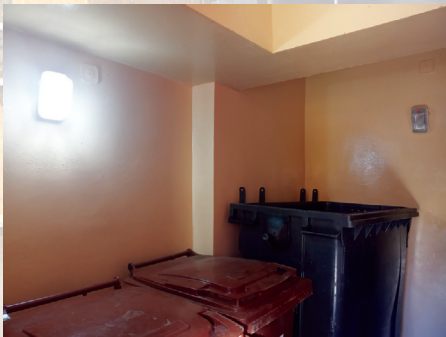
Remont komór zsympowych ul. Wlk. Niedźwiedzi 1-14 i 15-27
