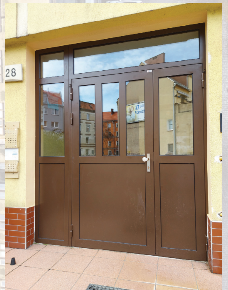
Nowe bramy wejściowe do budynku ul. Daszyńskiego 28-30
