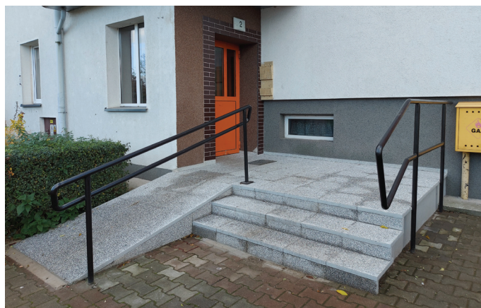
Nowe dojście do klatki schodowej - schody - ul. Kosmiczna 2, 3, 4, 10
