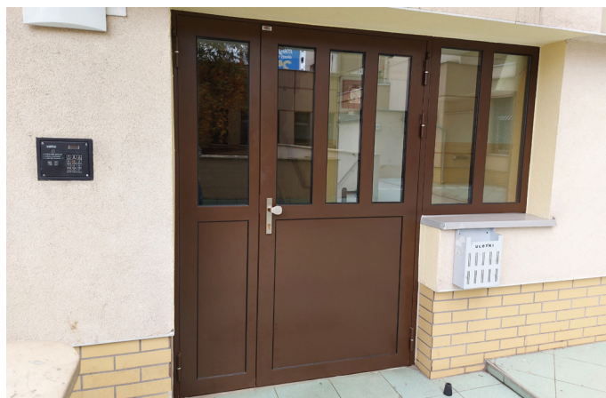
Nowa brama wejściowa do budynku - ul. Wrocławska 28
