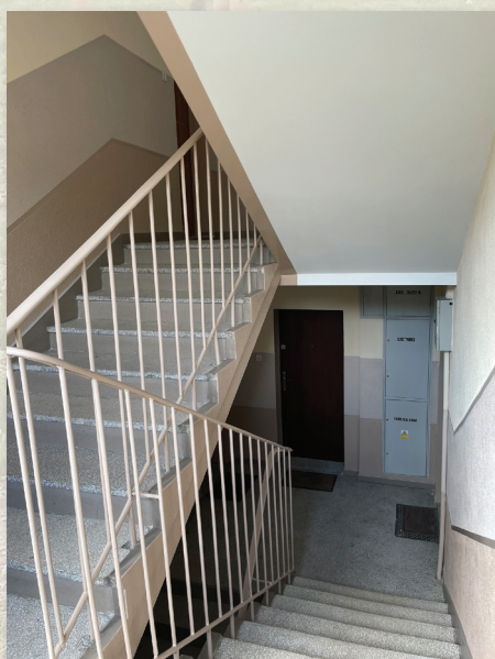
Remont klatki schodowej, ul. Orzeszkowej 18-24 kl. C
