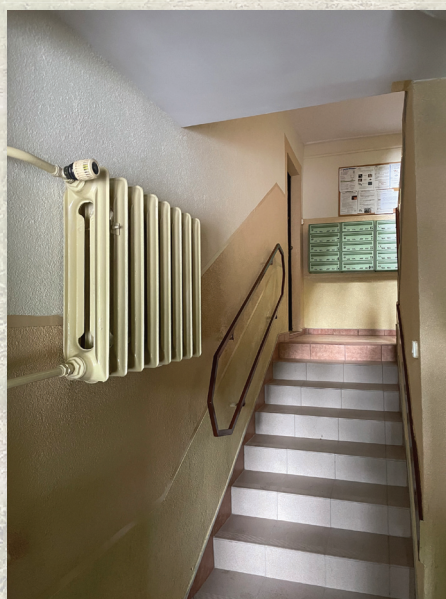
Remont klatki schodowej, ul. Horyzontalna 4
