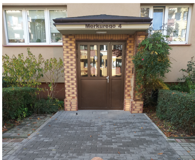
Remont dojścia ul. Merkurego 1-12
