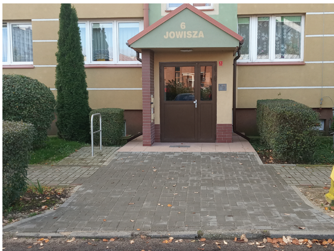
Remont dojścia do ul. Jowisza 1-12
