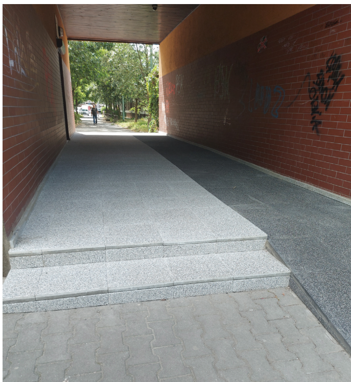
Remont przejścia blokowego - ul. Andromedy 1-12
