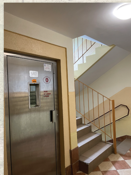
Remont klatki schodowej, ul. Galileusza 2
