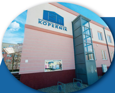
Spółdzielczy Dom Kultury „Kopernik” przy ul. Koziorożca 14 w Legnicy
